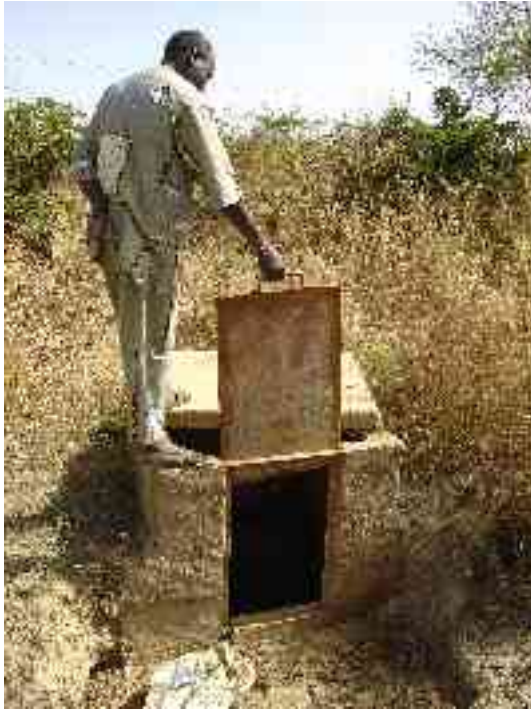
L'ouvrage de vidage du bas fond
