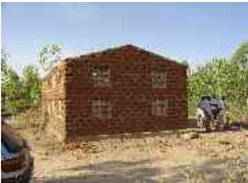
Un exemple de construction en brique de latérite donnant une idée de ce que serait la ferme
